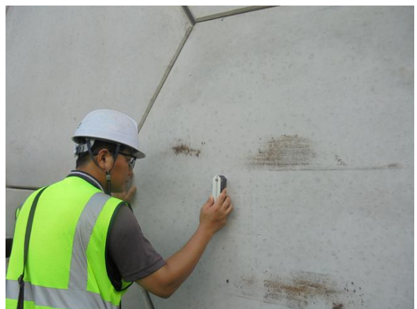
경사계를 이용한 경사도 측정
