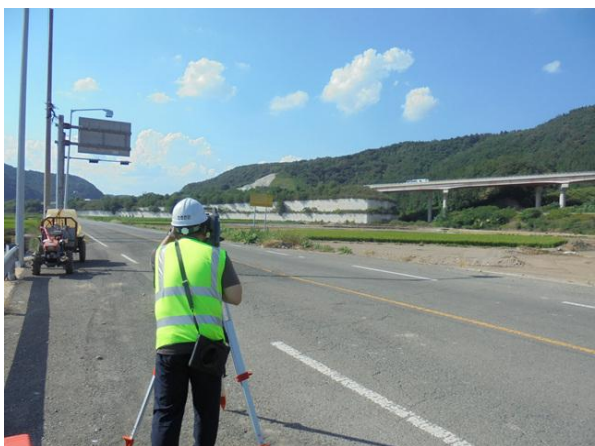
광파기를 이용한 측량 작업
